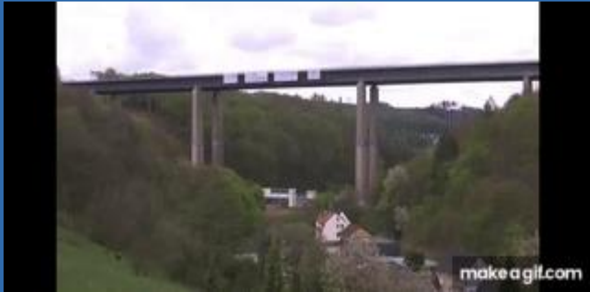
Sprengung der Rahmedetalbrücke A45 (07.05.2023)
